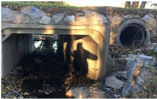
Ouvrage équipé d'une buse sèche sur le Vicoin - ©JAVO
